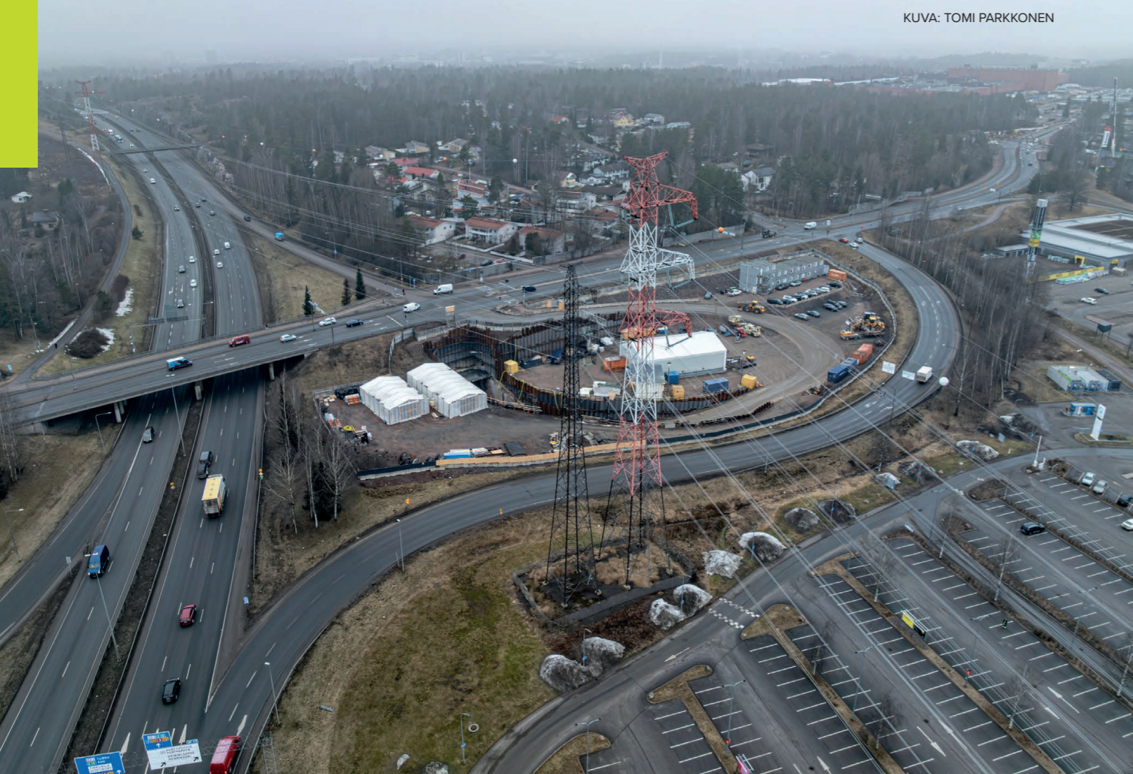
Varannon työmaalla Kehä III:n ja Vanhan Porvoontien ramppialueella maaliskuussa 2026.
