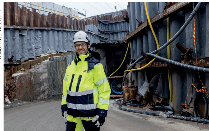
Vantaan Energian Kalle Patomeri Varannon työmaalla maaliskuussa 2026.
