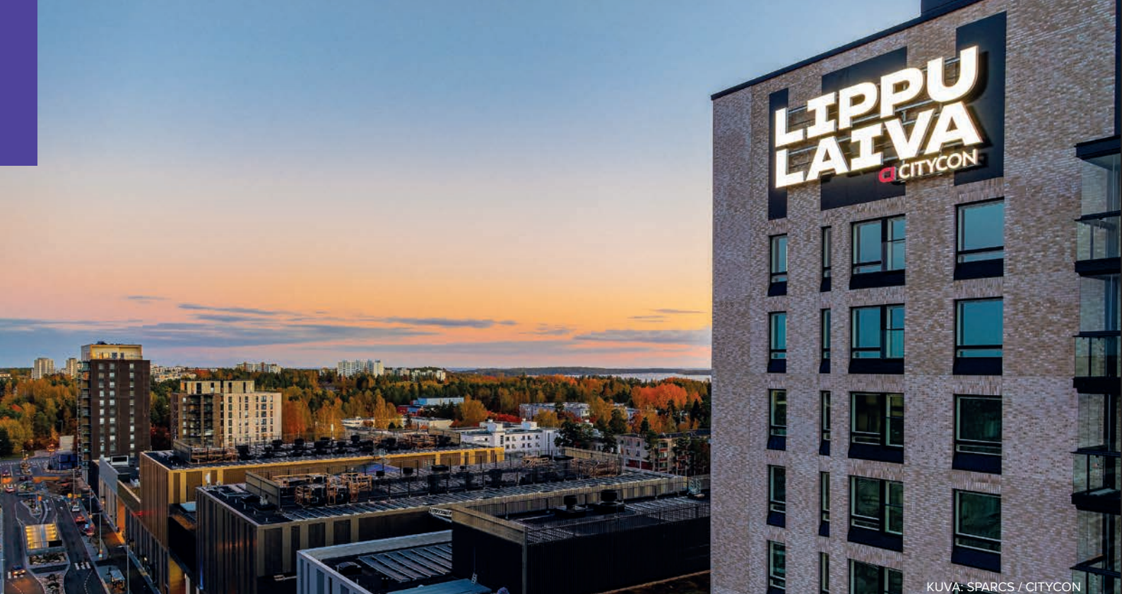
Espoon Lippulaiva-kauppakeskuksen keskuskortteli lämpenee kokonaan uusiutuvalla energialla.
