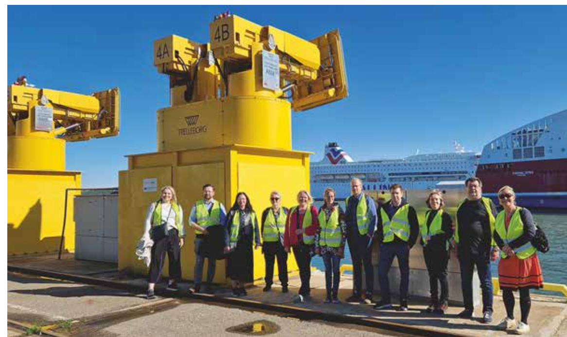
Tallinnan sataman automooring-laitteet nopeuttavat laivan kiinnittymistä laituriin.
