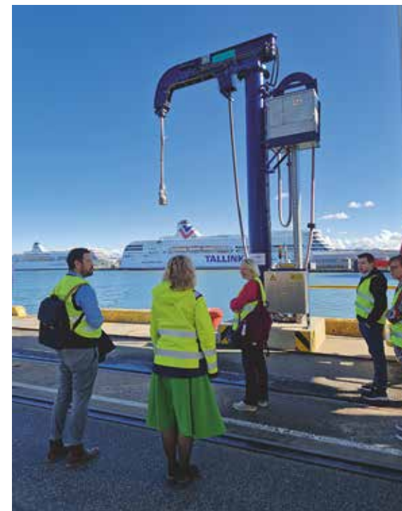
Maasähkölaite Tallinnan satamassa auttaa vähentämään alusten päästöjä satamassa.
