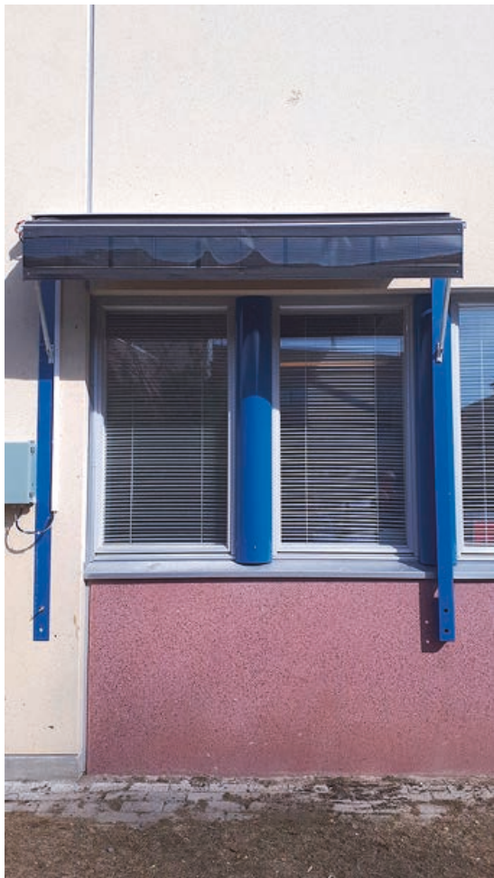
Kuva 4. Ohuet, orgaaniset aurinkopaneelit integroituna lasielementtiin ja aurinkosuojaan.
