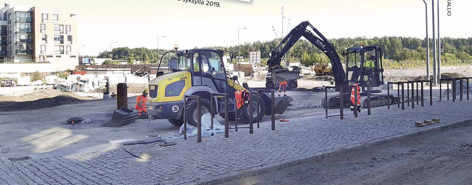
Päästötön työmaa Espoon Suurpellon Lukutorilla.
