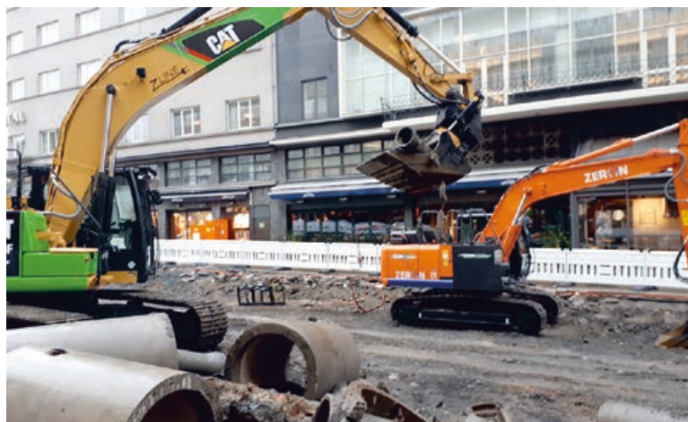
Päästöön työtä käynnissä Storgatanilla.
