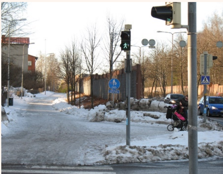
Kuva 4 ja 5. Kevyen liikenteen väylä viherkaistan ja meluaidan suojassa. Viherkaista on ilmansuojelun kannalta meluaitaa parempi ratkaisu ja meluaitakin on parempi kuin pyörätie aivan väylän varressa. Kuvat Hannu Airola.
