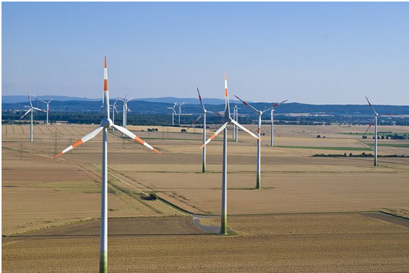
Kuva 3. Tuulivoimapuisto Ala-Saksin osavaltiossa Saksassa. Tuulivoimalat on asetettava tietyn välimatkoin toisistaan lapojen aiheuttaman turbulenssin vuoksi.
